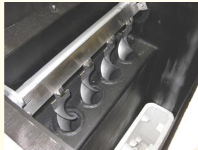
• Zde je vidět, jak vysoko vyjíždějí virbulátory, kterými se čistí povrch vnitřních částí teplovodního výměníku.
