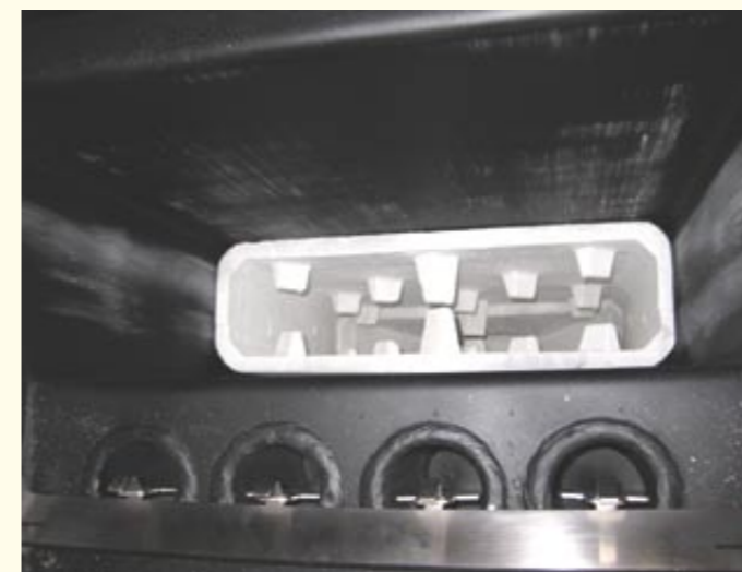
• Pohled shora do vyhořívací komory a teplovodního výměníku s poloautomatickým čištěním vnitřních stěn výměníku.
