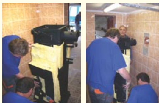
Po demontáži kotle je prováděna jeho zpětná montáž. Nastrojování kotle izolacími a dalšími komponenty.
