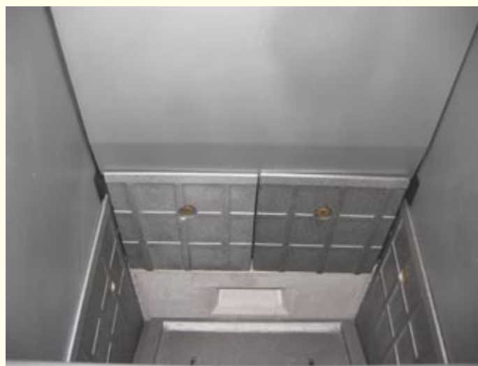
• Pohled na celou příkladací komoru. Obdélníkový otvor dole je tryska, kterou proudí vyvinutý dřevoplyn o teplotě cca 400°C do druhé části kotle, kde je smíchán se sekundárním vzduchem a vyhořívá při teplotě 1200°C.
