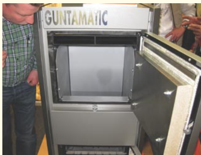
• Velký příkladací prostor umožňuje vkládat špalky až 33 cm dlouhé. Dole pod dvířky je vidět spínač, který aktivuje v případě otevření odtažový ventilátor tak, aby nedošlo k zakouření obslužného prostoru. Spaliny a kouř je nasáván do kanálu, který je vidět nad příkladací komorou. Vnitřní část příkladací komory je vystlána nerezovými plechy, které lze v případě poškození jednoduše demontovat a vyměnit. Směr otevírání příkladacích dvířek je možno zaměnit. • Pohled do spodní části příkladací komory. Celý prostor, ve kterém je vytvářen dřevoplyn z dřevěného uhlí vzniklého z kusového dřeva, je vyložen litinovými pláty, u kterých nehrozí rozbití a rozdrolení, jako se děje u kotlů, které v tomto prostoru mají šamot nebo keramiku.
