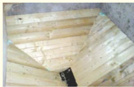
Montáž výdřev pod úhlem 40 stupňů v sezónním zásobníku paliva.
