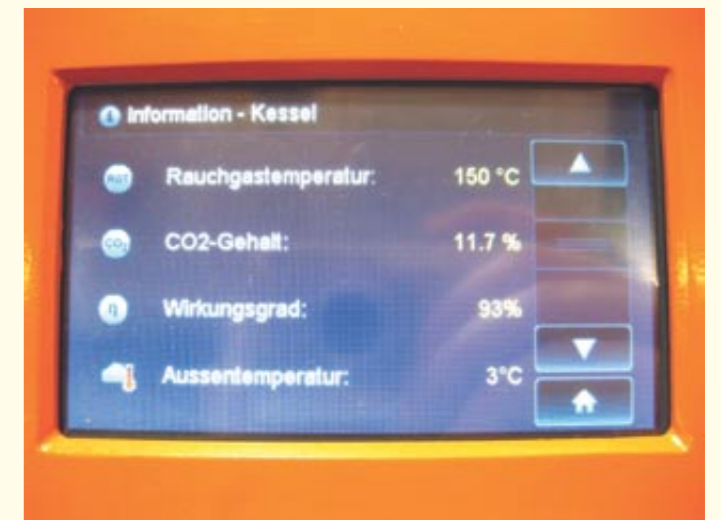
• Další obrazovka zobrazuje informace o teplotě spalin, obsahu CO2 ve spalinách, účinnosti a venkovní teplotu.
