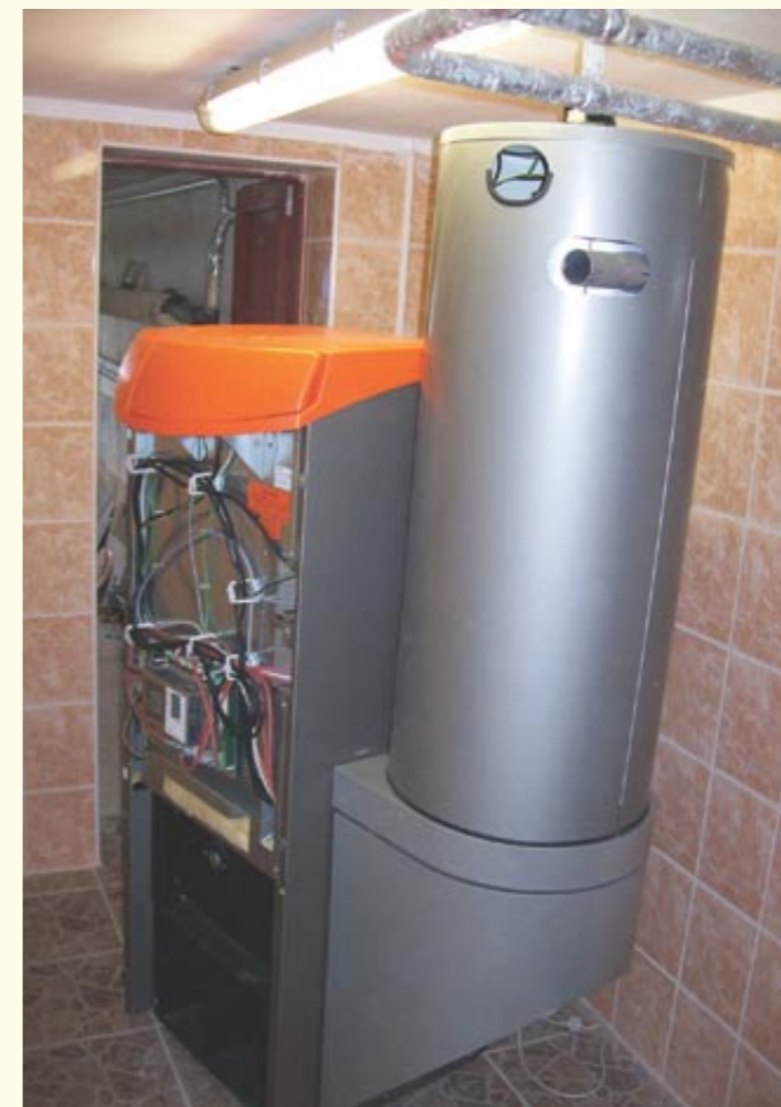
Usazení kotle do kotelny a zahájení instalace potrubních rozvodů.
