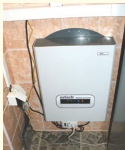
Off-line záložní zdroj elektrické energie ESUPS zajišťuje souvislou dodávku elektřiny pro zařízení, která nesmějí být neočekávaně vypnuta.
