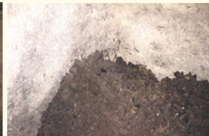
Původní kotel byl na hnědé uhlí kostka, které zde bylo ještě v době vypracování cenové nabídky na realizaci kotelny Guntamatic.
