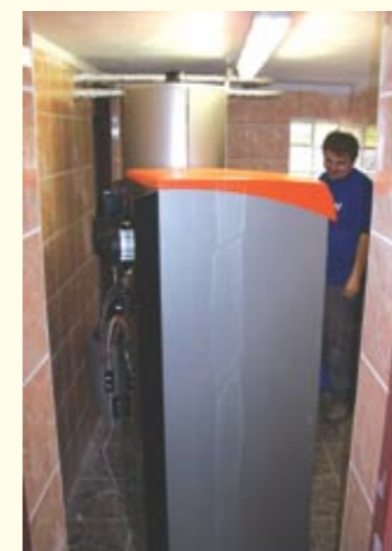
Nastěhovaný kotel v kotelně před jeho připojením do systému.
