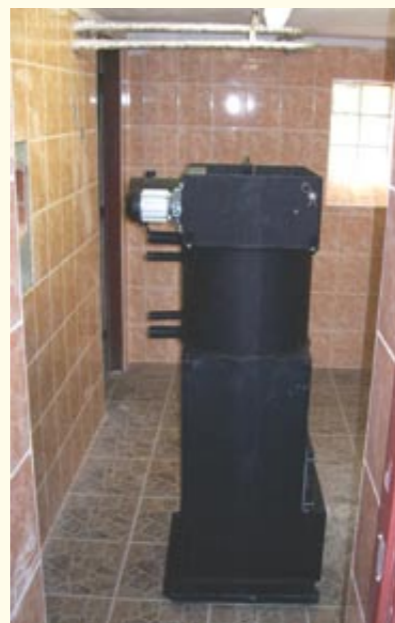
Odstrojený kotel po zpětném složení spalovací komory a výměníku.
