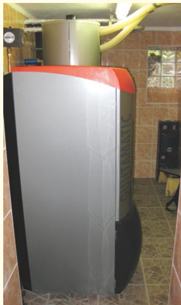
Kotelna Guntamatic BIOSTAR spuštěná do provozu po odjezdu firmy ESEL.
