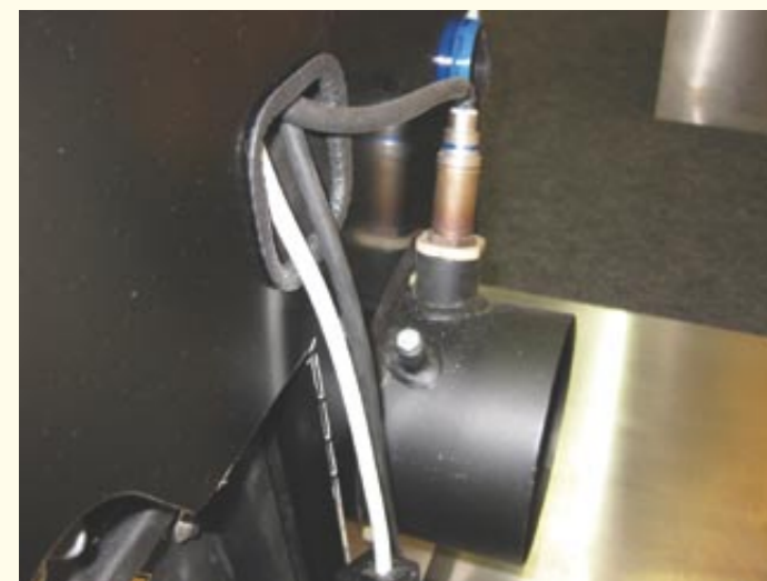
• Pohled do dolní zadní části, kde se nachází kouřovod s lambda sondou.
