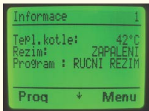
Detail LCD jednotky kotle.
