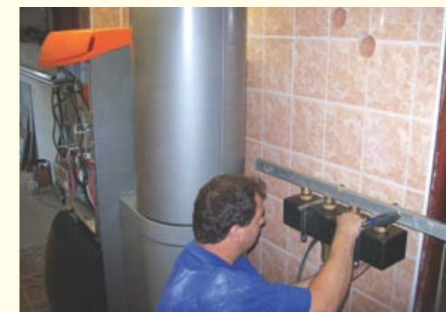
Usazení kotle do kotelny a zahájení instalace potrubních rozvodů.
