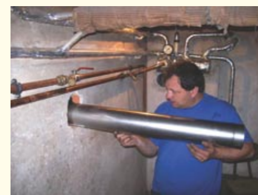
Montážník firmy ESEL (Vladimír Fiedor) provádí instalaci nerezového kouřovodu z kotle do komína.
