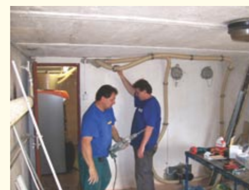
Montážník firmy ESEL (Vladimír Fiedor) provádí instalaci nerezového kouřovodu z kotle do komína.
