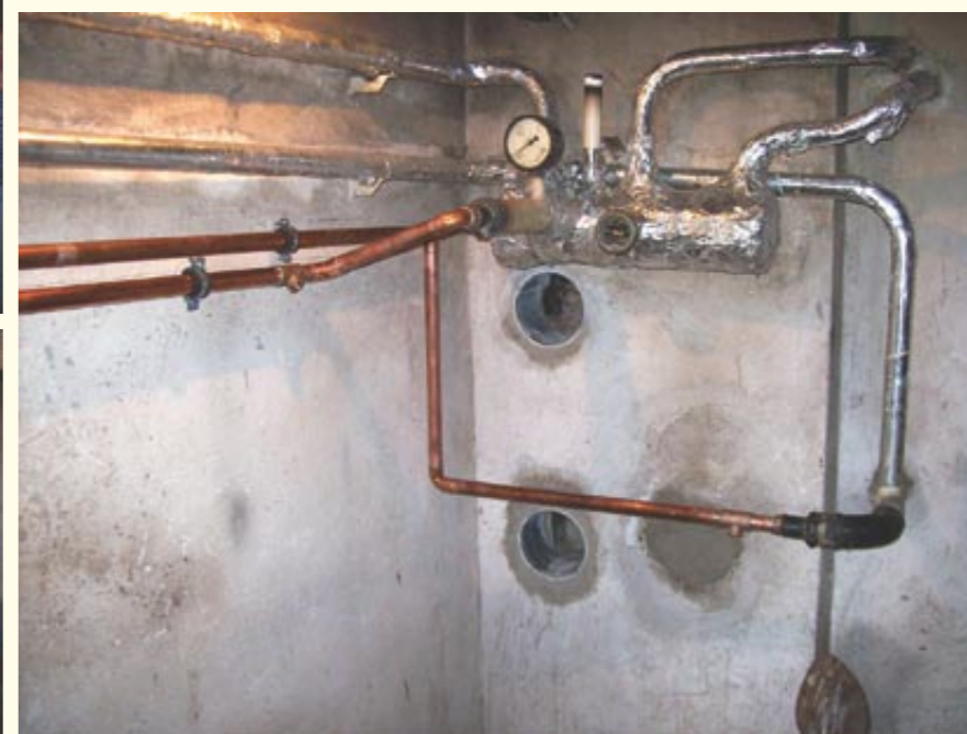
Stávající komín je připraven pro instalaci. V komíně je připravena zděř pro kotel i pro regulátor komínového tahu ESREKO.
