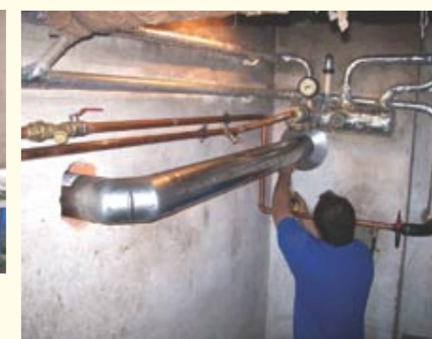
Stávající komín je připraven pro instalaci. V komíně je připravena zděř pro kotel i pro regulátor komínového tahu ESREKO.
