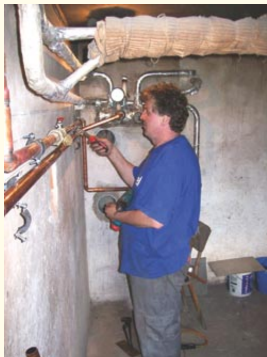
Montáž potrubních rozvodů mezi starou a novou kotelnou.
