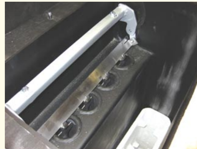
• Zde je vidět, jak vysoko vyjíždějí virbulátory, kterými se čistí povrch vnitřních částí teplovodního výměníku.
