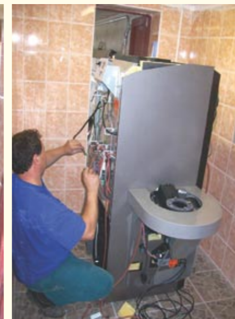
Kompletace elektročásti kotle.
